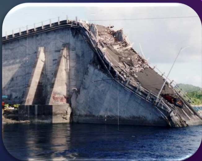
รูปการขยายตัวของรอยแตกจากการล้า: Koror-Babeldaob Bridge เสียหายด้วยกลไกการล้า
